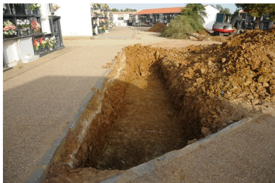
Figura 70. Vista general del sondeo mecánico 03.
