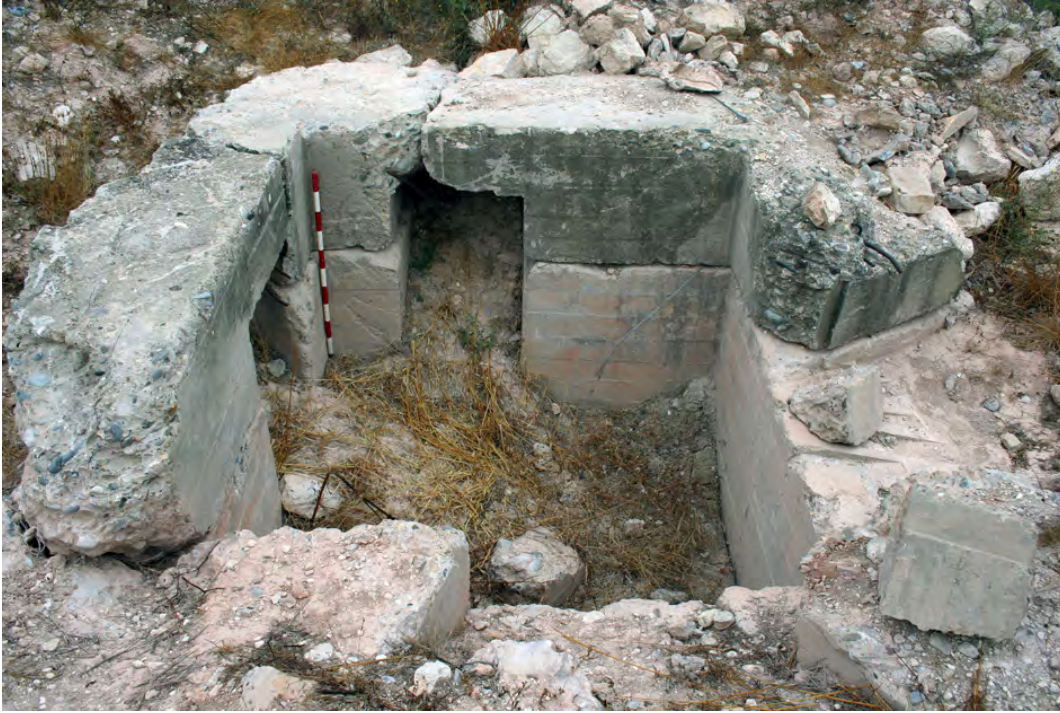
Figura 36. Fortín 04. Vista desde el N del interior, con las puertas que dan a las galerías.
